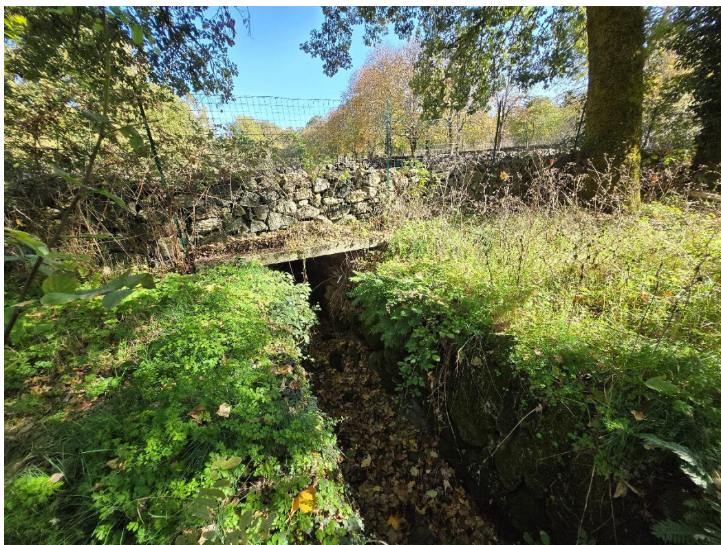
CANALIZZAZIONE ATTUALE IN PIETrame A SEZIONE RETTANGOLARE
